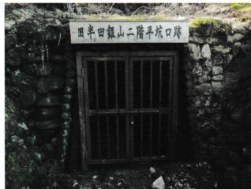
旧半田銀山二階平坑口跡
