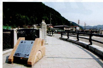
盛明橋：橋名は1875年の完成当時、生野鉱山長であった朝倉盛明の名が付けられた。当初、木製の橋だったが、永久橋へ架け替え、1999年に架橋工事が行われた。
