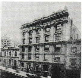
シドニーの兼松ビル
